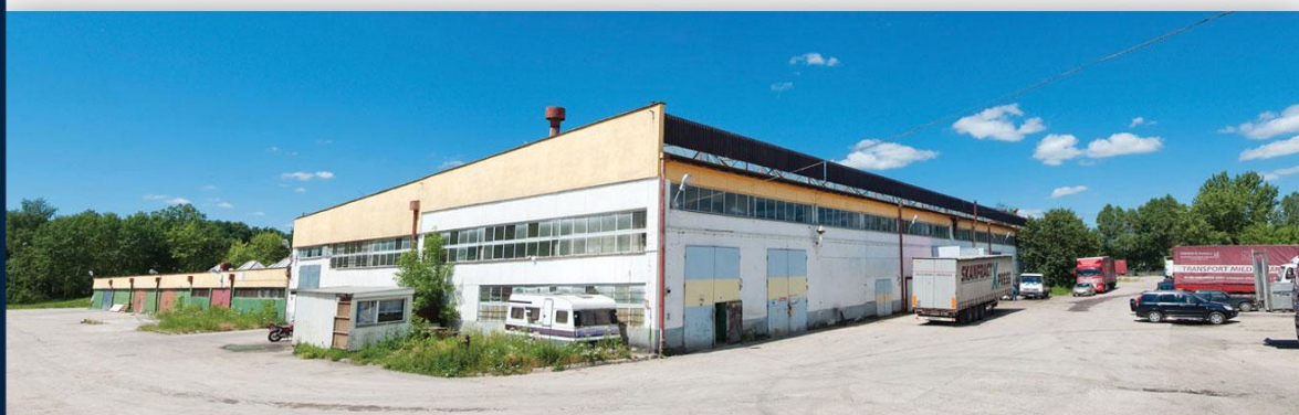
Widok na hale wysokiego składowania
